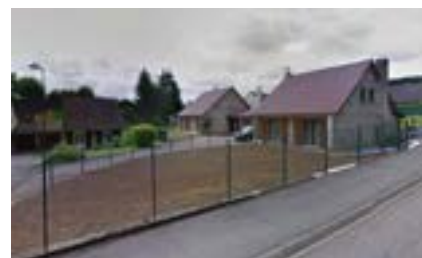
Clôture en grillage
